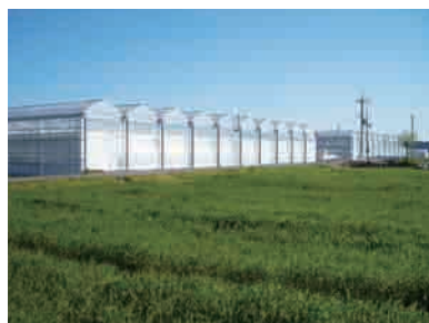
高軒高ハウス
