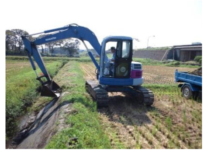
＜河川工事の様子＞
