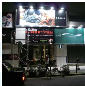
ローリングタワー足場
