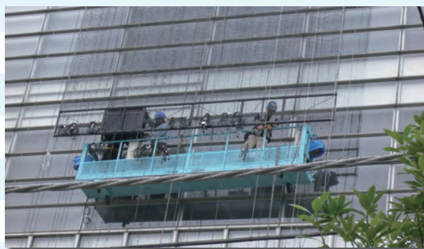
ゴンドラ足場
